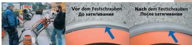
Правильно закрепленная буровая машина.
