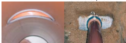
Правильная посадка седловой опоры в канализационной трубе FABEKUN®.
