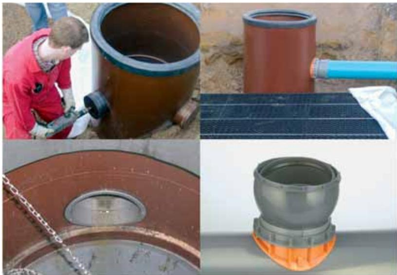
Над бермой смотрового колодца возможно подключение дополнительного домового выпуска при помощи стыкового элемента CONNEX®.
